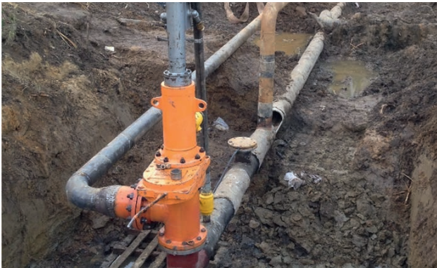
ОДНОСТОРОННЕЕ ПЕРЕКРЫТИЕ ГАЗОПРОВОДА DN 500 И DN 250
