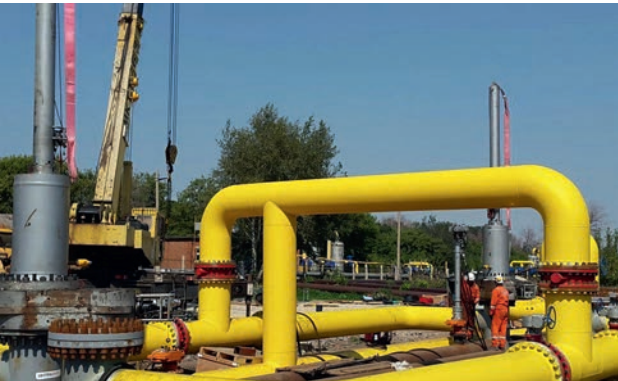
ПЕРЕКРЫТИЕ УЧАСТКА ГАЗОПРОВОДА DN 700
