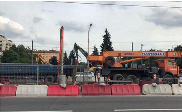
ДВУХСТОРОННЕЕ ПЕРЕКРЫТИЕ ГАЗОПРОВОДА DN 700
