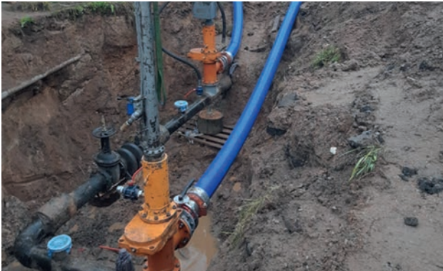
ДВУХСТОРОННЕЕ ПЕРЕКРЫТИЕ ТРУБОПРОВОДА DN 150
