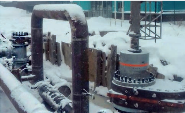
ДВУХСТОРОННЕЕ ПЕРЕКРЫТИЕ ГАЗОПРОВОДА DN 400
