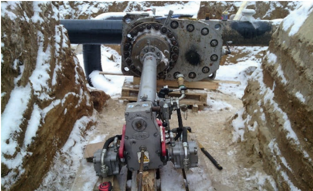
ВРЕЗКА И ПЕРЕКРЫТИЕ ГАЗОПРОВОДА DN 400 В ТРЕХ ТОЧКАХ ЧЕРЕЗ ТРОЙНИКИ С БОКОВЫМ ОТВОДОМ
