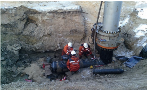
ДВУХСТОРОННЕЕ ПЕРЕКРЫТИЕ ГАЗОПРОВОДА DN 700
