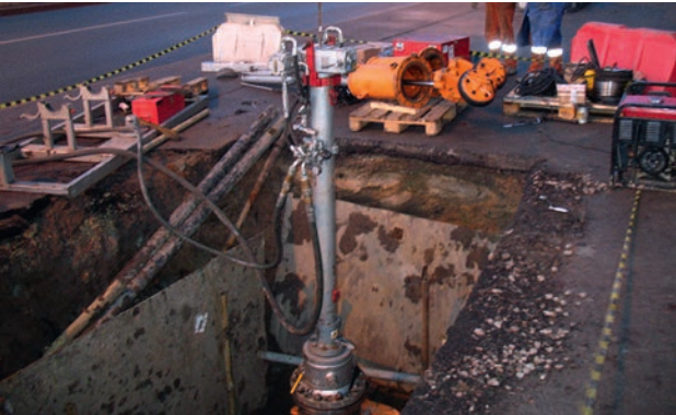
ДВУХСТОРОННЕЕ ПЕРЕКРЫТИЕ Б ГАЗОПРОВОДА DN 250
